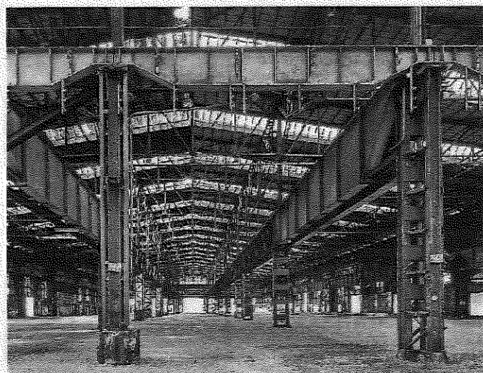
CENTENARIO Le acciaierie Beltrame di Porto Marghera in una delle immagini del fotografo Giorgio Bombieri
