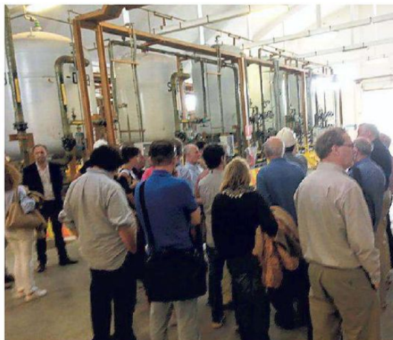
Visita all'impianto di trattamento delle acque di falda
